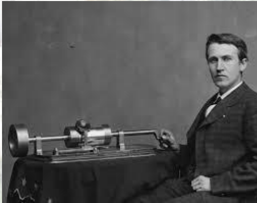
У США запатентовано перший фонограф для запису звуку, винайдений Томасом Едісоном (циліндричний валик, обгорнутий олов'яною фольгою, покритою шаром воску, з голкою й мембраною) (1887)
